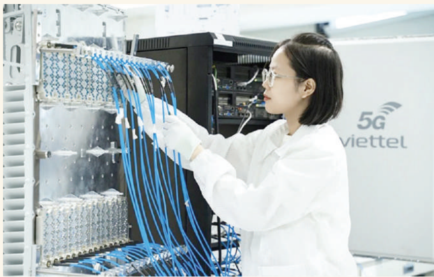
Kỹ thuật viên lắp đặt thiết bị trạm gốc 5G. Ảnh sưu tầm/ A technician installs equipment at a 5G base station. Collective photo
