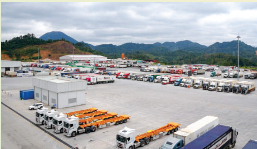
Công viên Logistics Viettel Lạng Sơn. Ảnh sưu tầm/ Viettel Lang Son Logistics Park. Collected photo
