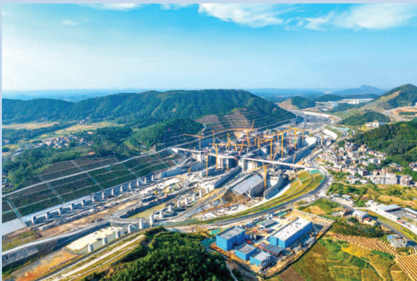
Một đoạn của Kênh đào Bình Lục trong quá trình xây dựng. Ảnh sưu tầm
